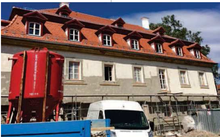
Die neue denkmalgeschützte Geschäftsstelle von „Dyrbusch & Uhl“ im Herzen Waldsassens. Auf dem Foto noch mitten im Umbau, wird im November endlich in neuem Glanz erstrahlen!
